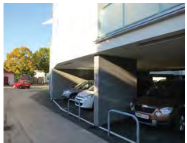
Abb. Parkgarage statt Erdgeschoß künftig zu vermeiden; Quelle: Foto A I R
